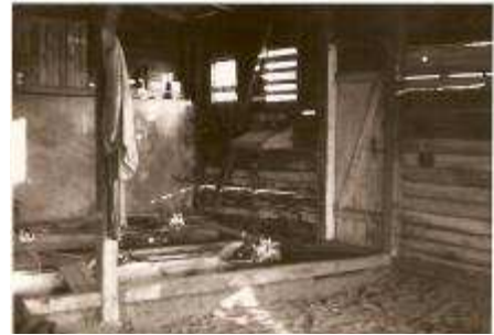
Bild 9: Blick ins Innere vor dem Umbau.....
