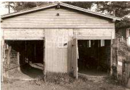
Bild 8: Desolater Zustand des Bootsschuppens der Holstenschule
